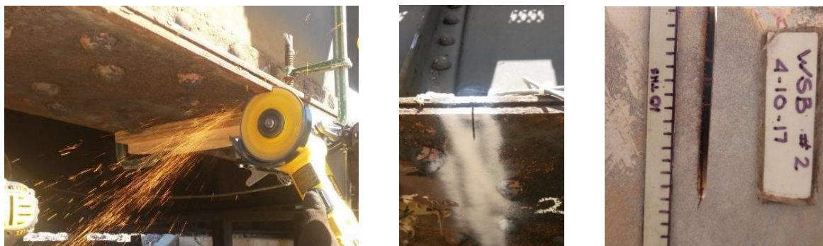
Rys. 8 Nacięcia w dolnej półce blachownicy o rozpiętości 9,75 metra (32 stopy) oraz propagacja pęknięcia
